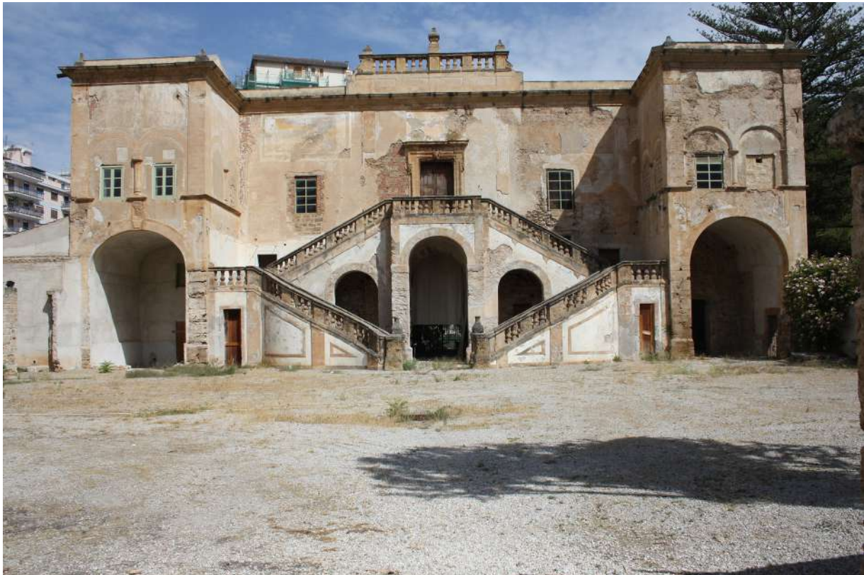
Fig.3. Villa Napoli. Prospetto sud
