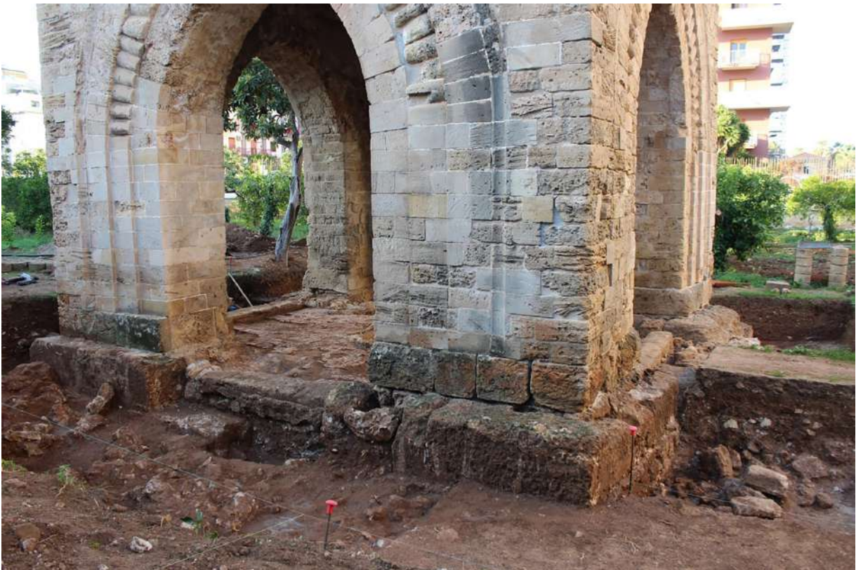
Fig. 36. Palermo. Piccola Cuba. Basamento durante la excavación
