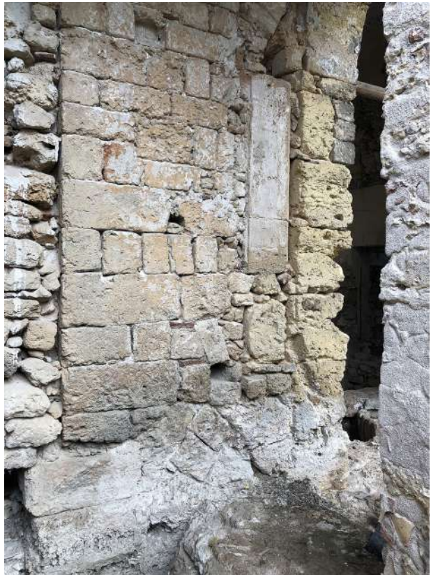
Fig.3a. Villa Napoli. Prospetto sud, particolare
