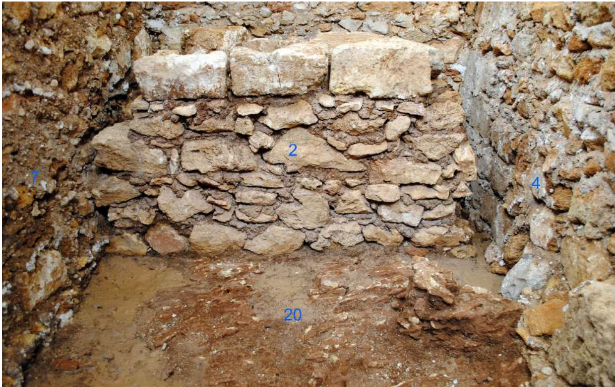
Fig. 15. Palermo, Cuba Soprana. Espacio 8. Vista desde el norte. Sobre la base rocosa (20), un fragmento de muro de mampostería (2) trabada con mortero terroso de color rojizo, perteneciente al edificio fundacional, aparece cortado por dos muros normandos (4 y 7) en los que es abundante el mortero de cal (foto LAAC, EEA, CSIC).
