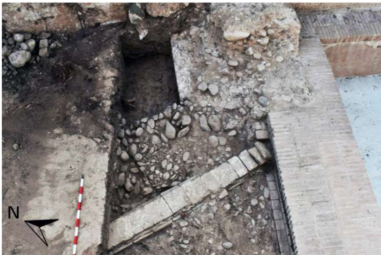
Fig. 8 Vista del sondeo 3200 con el contrafuerte de tapial en la parte superior al que se le adapta el muro de ladrillos del siglo XIX que hace las veces de límite del albercón.
