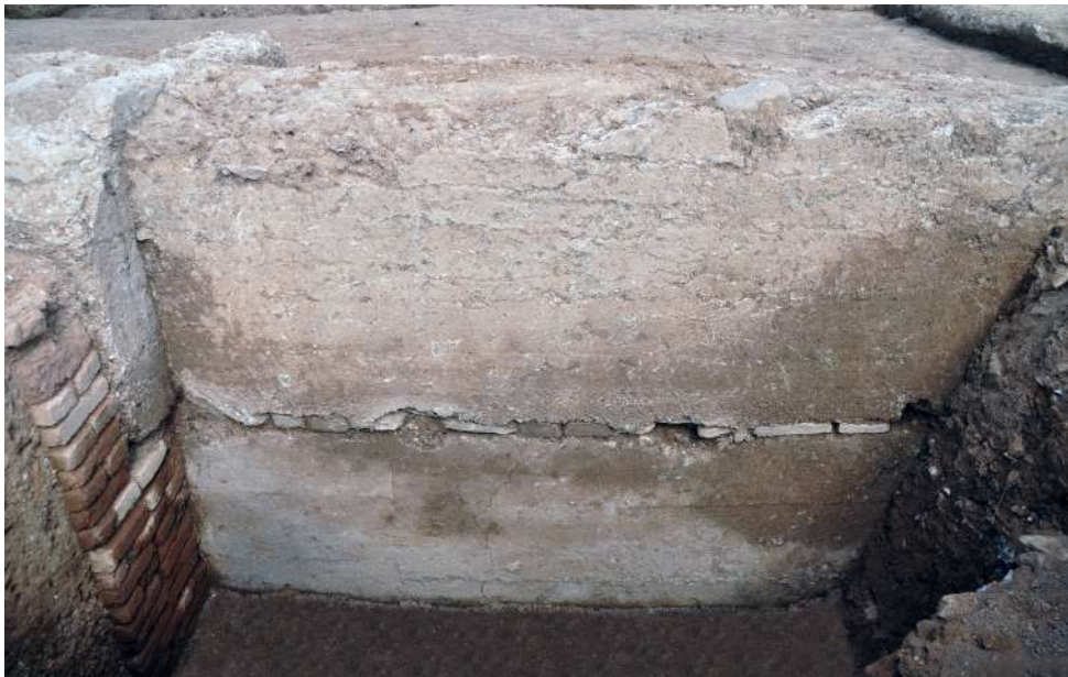
Fig. 17. Parcela II. Palacio de la alberca. Alcoba del pórtico. Sondeo. Vista desde el oeste de la cimentación de tapiería del muro oriental y del atajo. La separación de las tapias con una hilada de ladrillos es un dato constructivo singular que indica cómo se desarrolló la construcción. Foto: Juan Antonio Ramírez Águila.
