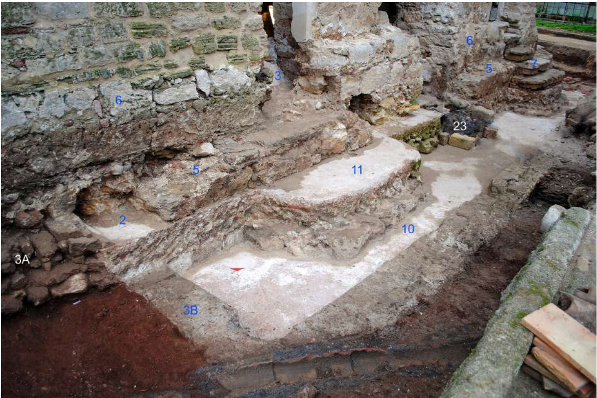
Fig. 23. Palermo, Cuba Soprana. Estanque. Vista desde el sureste. Los dos niveles de pavimento de la alberca (10 y 11). El 2 señala la ampliación del vaso de la alberca sobre el forro de sillería (3B) de la fase fundacional. El 23 corresponde al pozo de época moderna. El 5 es un banco y el 6 es un muro de refuerzo, ambos construidos en la reforma del siglo XVI (foto LAAC, EEA, CSIC).
