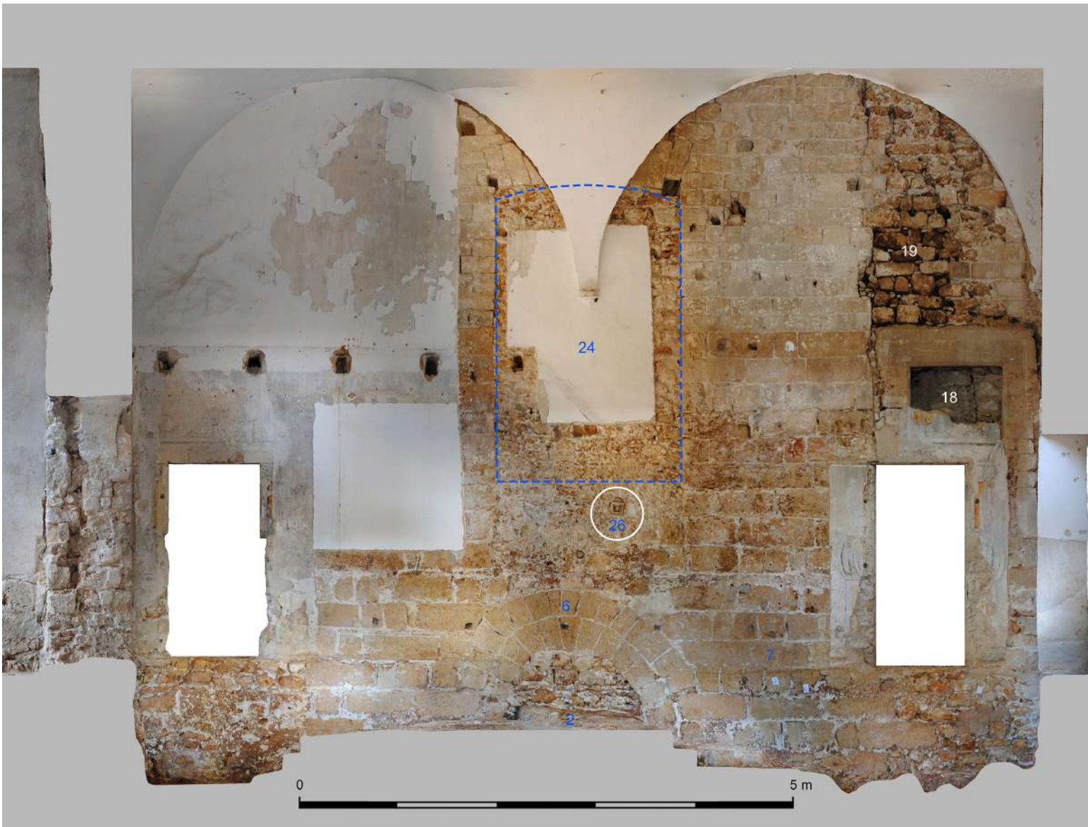
Fig. 32. Palermo, Cuba Soprana. Espacio 6. Ortofoto del alzado del muro normando (7) visto desde el este. El 24 es la puerta de acceso al salón de la planta baja. El 18 es un vano perteneciente a la fase bajomedieval en la que el edificio fue usado, probablemente, como palomar. El 19 es una obra de mampostería bajomedieval cerrando un vano normando. El 6 es el arco de descarga construido sobre la infraestructura hidráulica (2). El 26 es una caja de madera que probablemente se hizo para proteger el tubo metálico por el que llegaba el agua a las dependencias del frente oriental del pabellón, (LAAC, EEA, CSIC).
