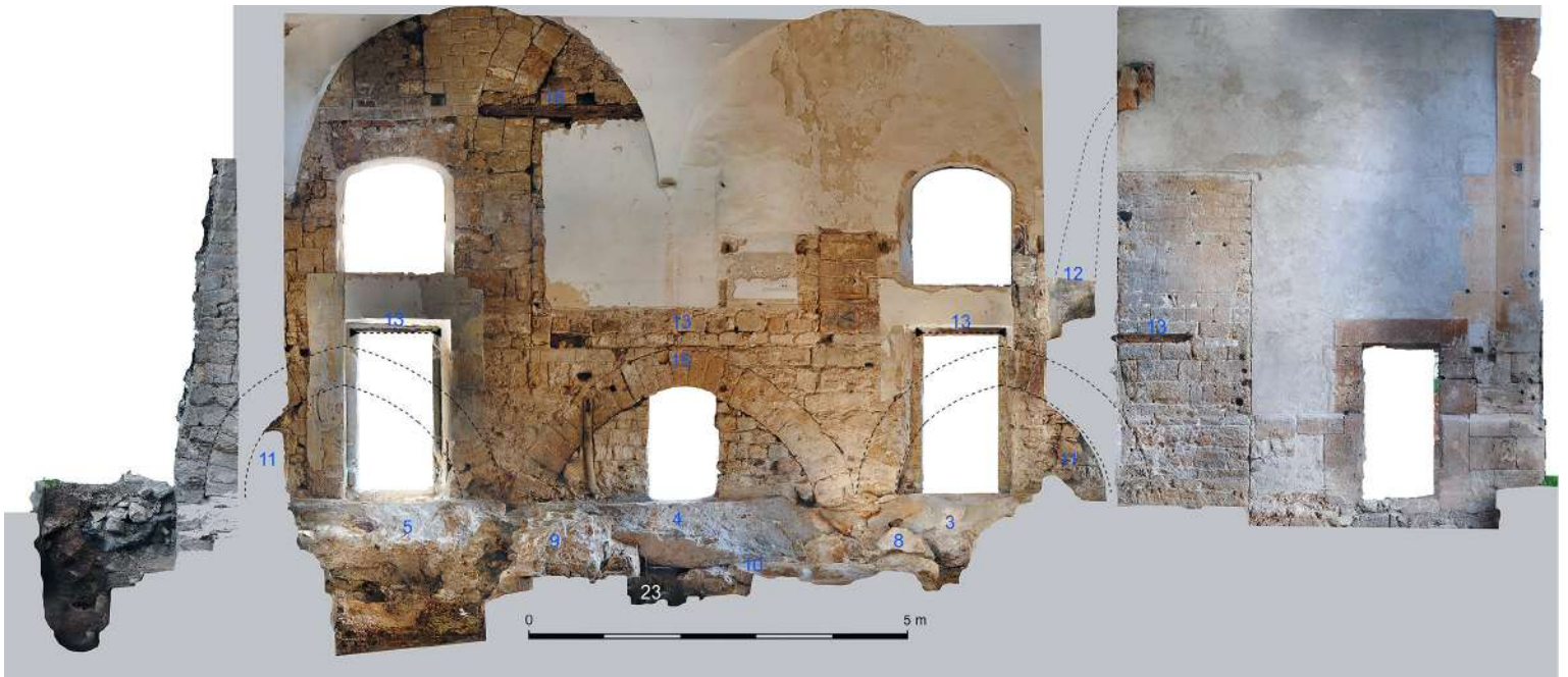
Fig.19. Palermo, Cuba Soprana. Espacio 6. Ortofoto de la pared oriental vista desde el oeste. En la fase II el edificio se amplió sobre la alberca y para ello fue necesario cimentar la nueva fachada sobre las tres grandes rocas (3,4 y5) a la vez que fueron cubiertas con tres bóvedas (11). Es en esta segunda fase cuando tenemos las primeras pruebas arqueológicas de donde estaba la cota de suelo de la plataforma (13), (LAAC, EEA,CISC).
