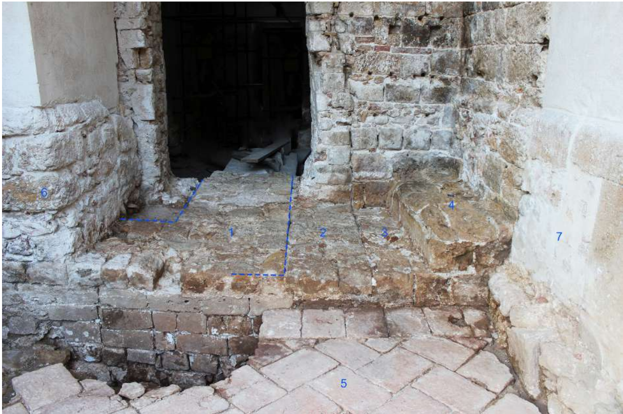
Fig. 31. Palermo, Cuba Soprana. Frente sur. Espacio 5. Muro de sillería perteneciente a la fachada del edificio fundacional (1). El nº 2 y 3 corresponden a la ampliación árabe de la fase II. El 4 es un banco del siglo XVI, retallado en la fábrica de sillería de la fase II. El 5 es un pavimento de grandes ladrillos que probablemente pertenezca a la fase normanda. El 7 es uno de los muros que sostienen la logia del siglo XVI (foto LAAC, EEA, CISC)
