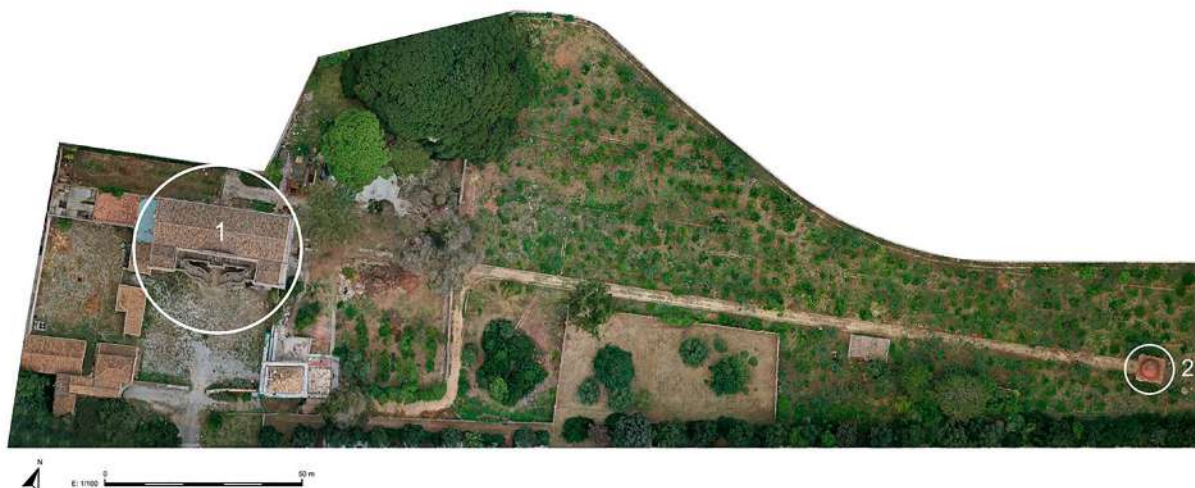
Fig. 3. Palermo, Villa Napoli. Vista aérea de la finca. Cuba Soprana (1) y Picola Cuba (2), (foto LAAC, EEA, CISC).
